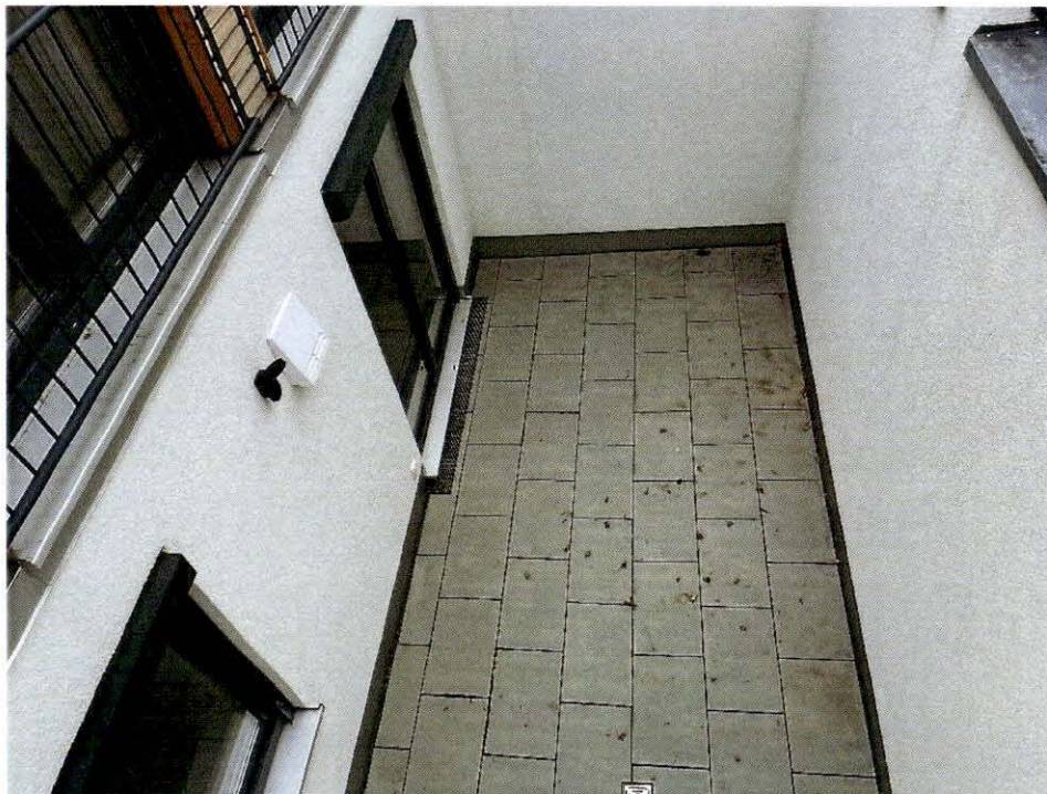
Foto 4: Blick in den Atrium-Lichtschacht
