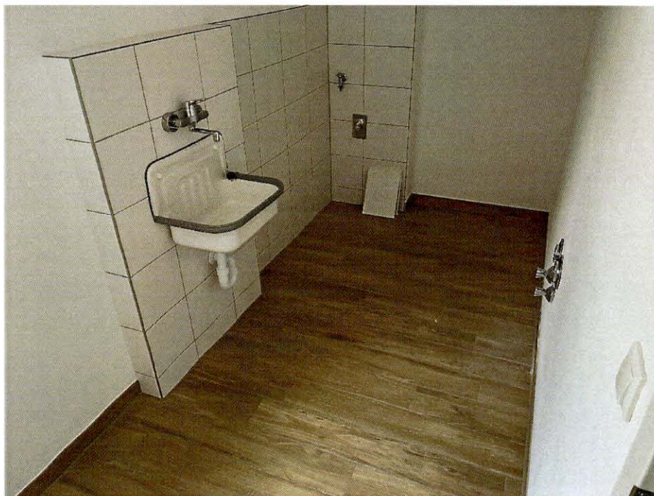
Foto 10: Blick in den Waschraum
