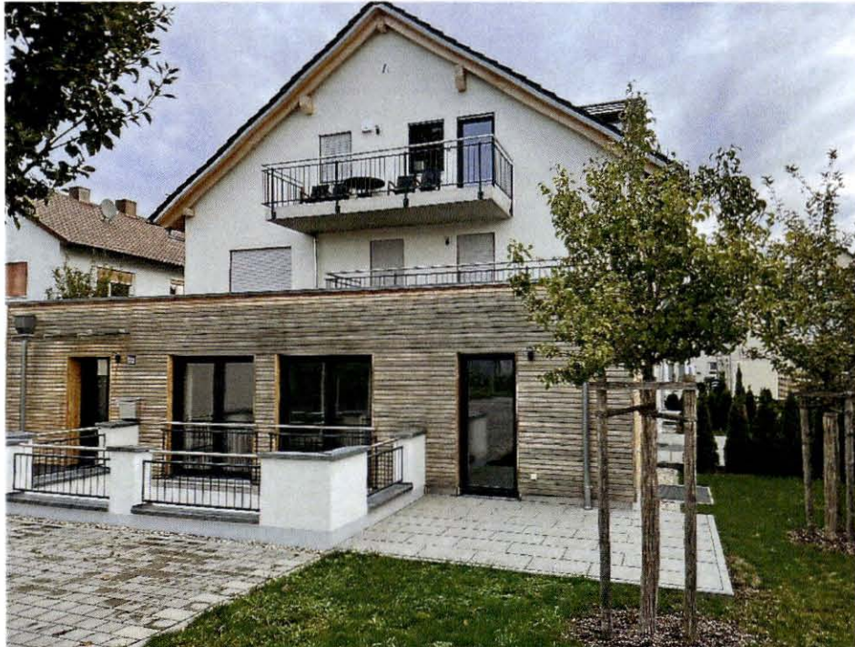
Foto 1: Ansicht von Westen
