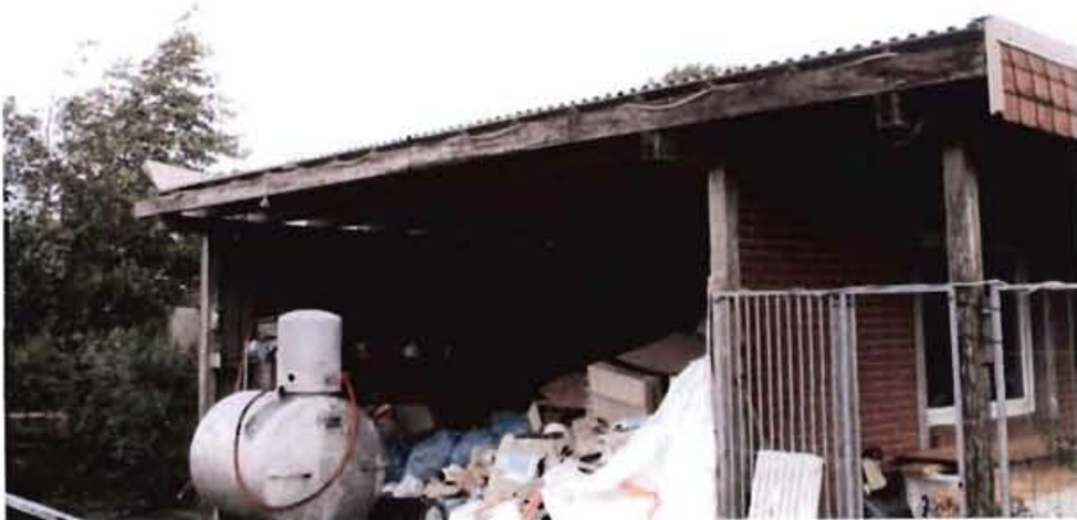
Südwestansicht des Doppelcarports
