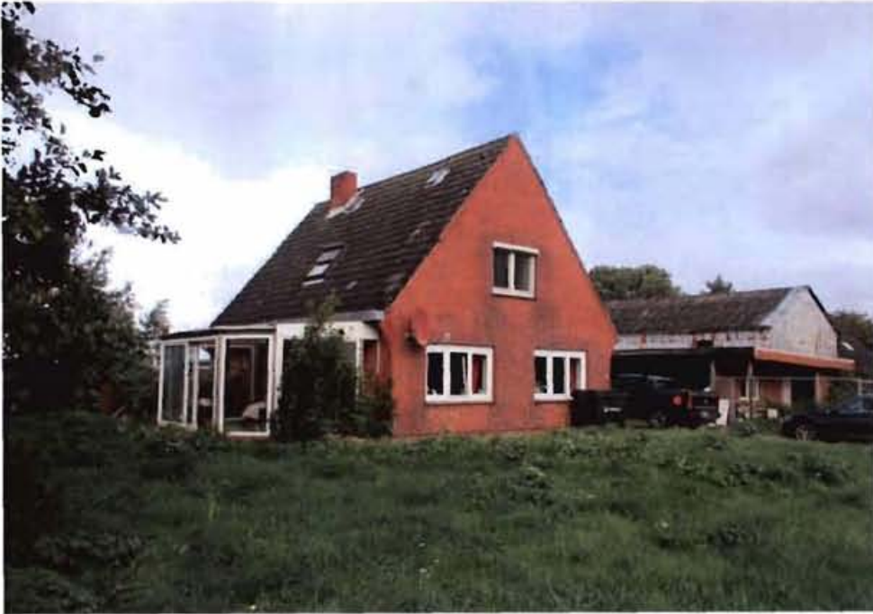
Südwestansicht des Wohnhauses mit Wintergarten
