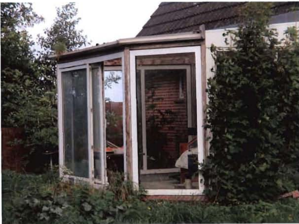
Detailansicht des westlichen Wintergartens
