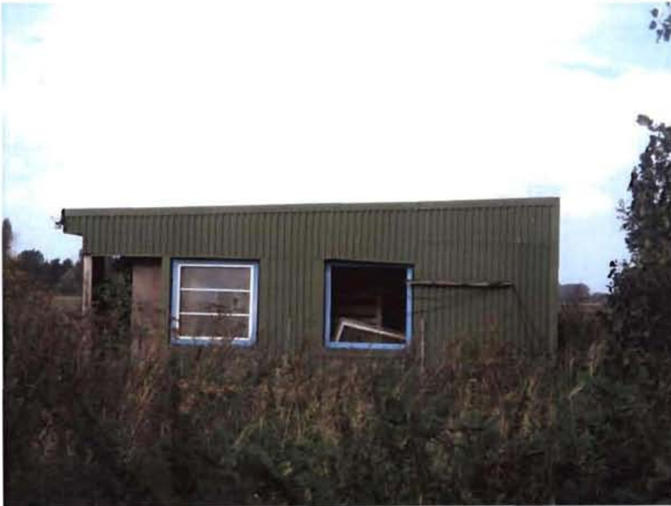
Südansicht des Lagergebäudes
