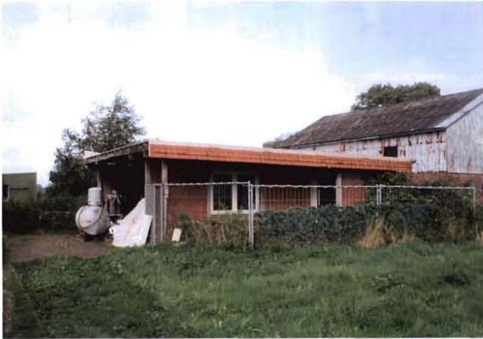
Südansicht des Doppelcarports
