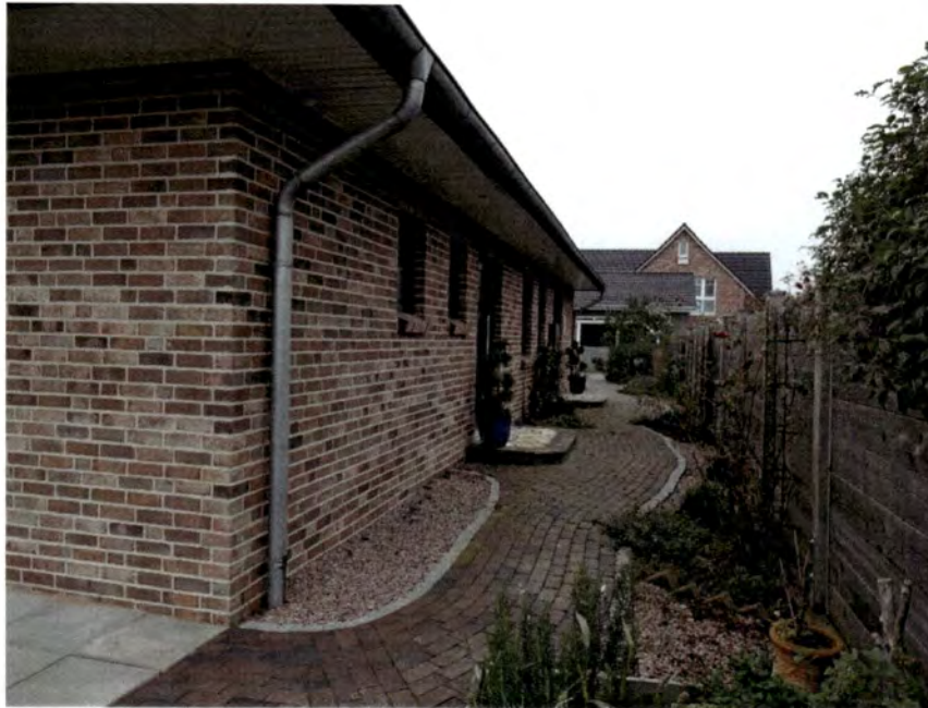
Bild 11: Blick entlang der Nordseite nach Westen
