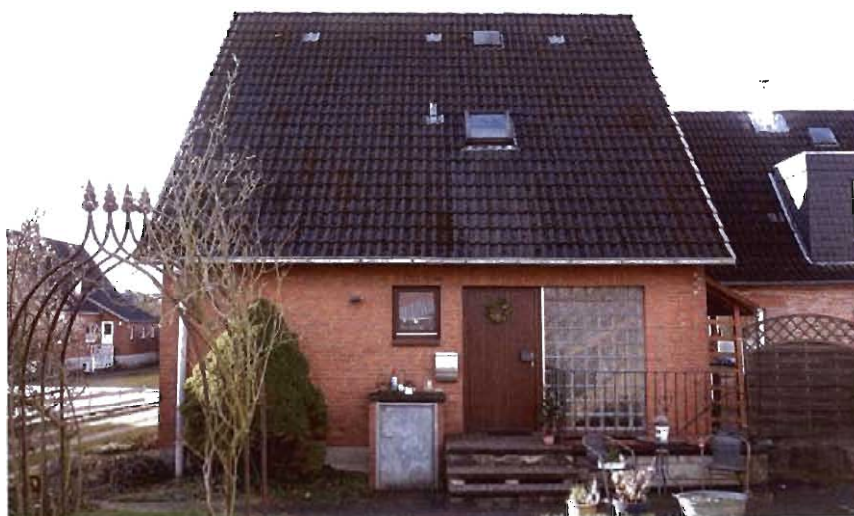
Bild 2: rückwärtige Nordansicht der Doppelhaushälfte
