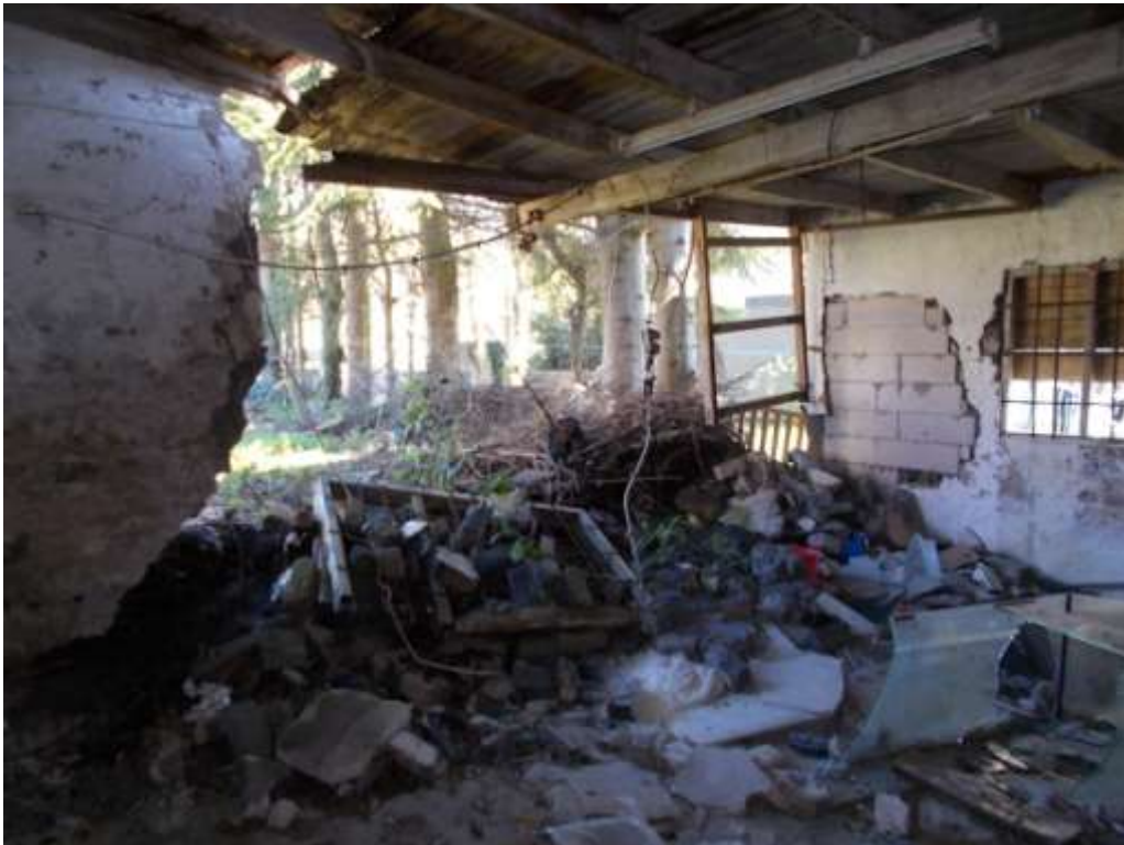
Innenansicht nördliches Nebengebäude
