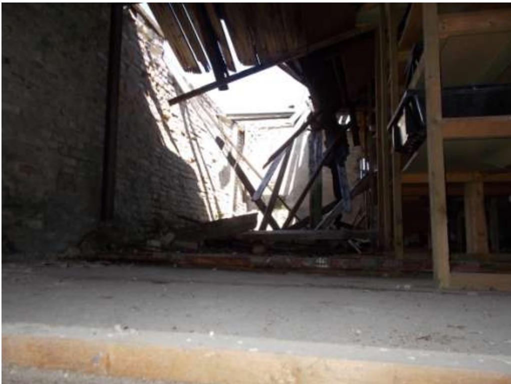
Innenansicht nördliches Nebengebäude
