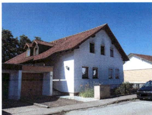
Nord- und Ostseite des Gebäudes
