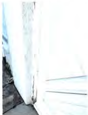
beispielhafte Ansicht der Farbabblätterungen im Bereich der Eingangstüre
