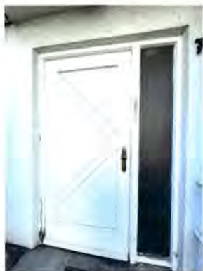
beispielhafte Ansicht der Eingangstüre an der Südwestseite
