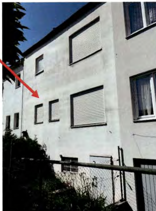
beispielhafte Ansicht der Nordostseite des zu beurteilenden Reihenmittelhauses
