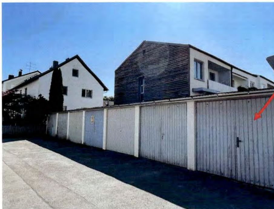
beispielhafte Ansicht der Garagenreihe mit der zu beurteilenden Reiheneckgarage
