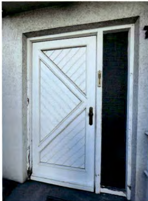
beispielhafte Ansicht der Eingangstüre an der Südwestseite des Reihenmittelhauses
