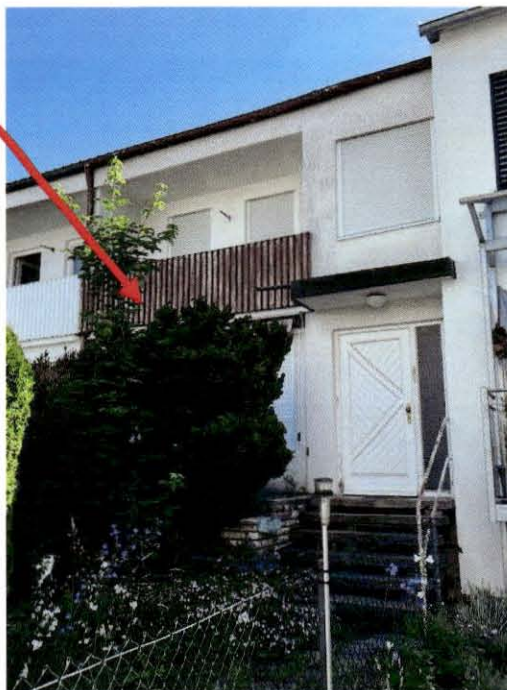
beispielhafte Ansicht der Südwestseite des Reihenmittelhauses – Max-Eyth-Straße 7
