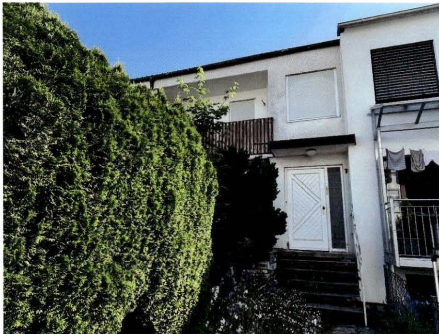
beispielhafte Ansicht der Südwestseite des Reihenmittelhauses – Max-Eyth-Straße 7
