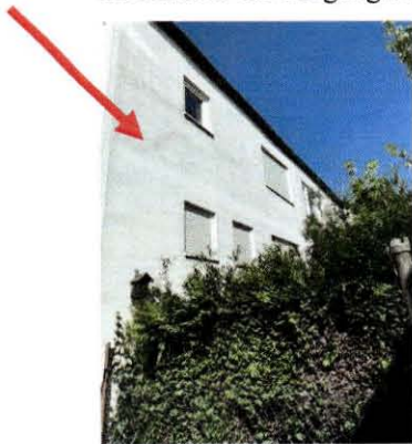
beispielhafte Ansicht an der Nordostseite der Fassade im Bereich des Obergeschosses
