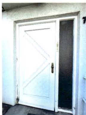
beispielhafte Ansicht der Eingangstüre an der Südwestseite
