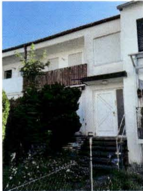
beispielhafte Ansicht der Südwestseite des Ein- familienhauses in Form eines Reihenmittelhau- ses
