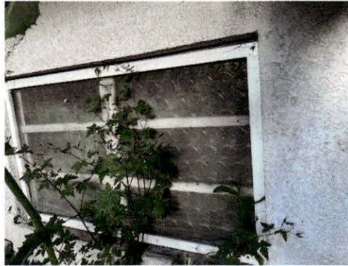
beispielhafte Ansicht eines Kellerfensters zur Südwestseite
