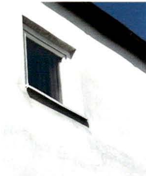
beispielhafte Ansicht des Fensters im Badezimmer des Obergeschosses
