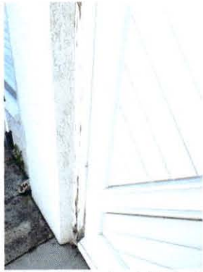
beispielhafte Ansicht der Farbabblätterungen im Bereich der Eingangstüre
