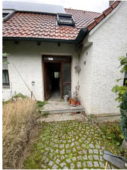
Bild 2 – Blick auf Hauseingang von Süden
