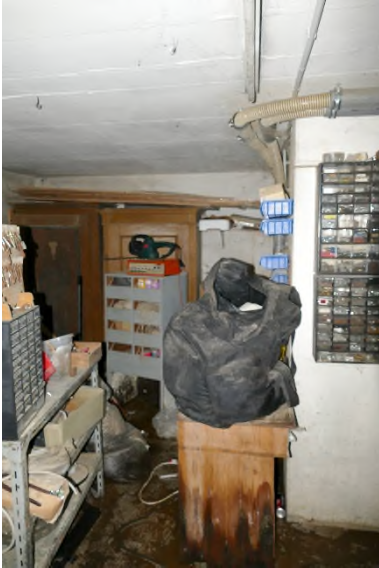
Bild 15 und Bild 16 – Keller Südwest
