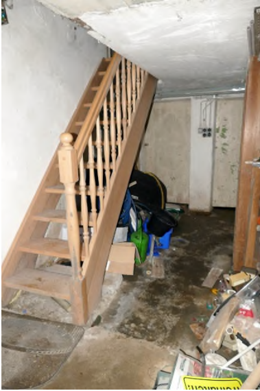
Bild 10 und Bild 11– Kellerflur Anbau
