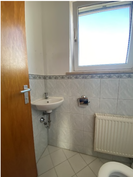
Bild 20 und Bild 21 – WC
