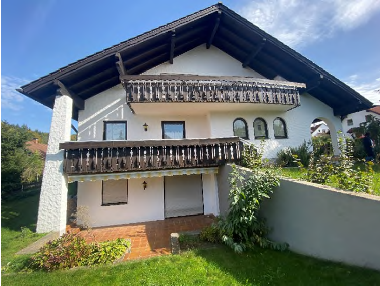
Bild 5 – Wohnhaus und Garage von Norden
