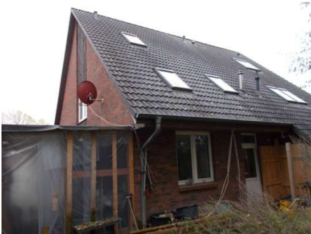
Rückwärtige Ansicht von Nord-Osten
