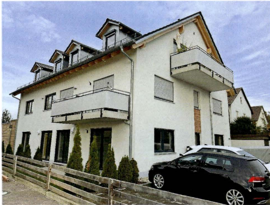
Foto 3: Ansicht von Südosten
