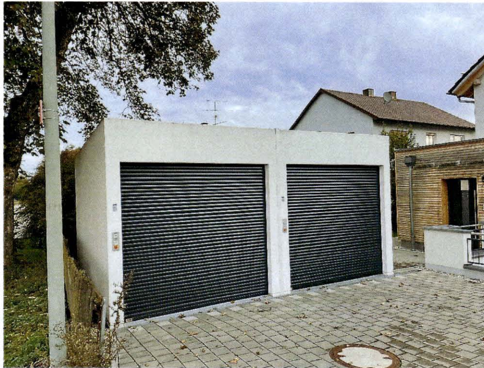
Foto 19: Duplex-Parker – Ansicht von Süden
