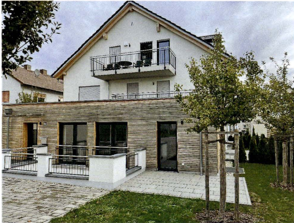
Foto 1: Ansicht von Westen
