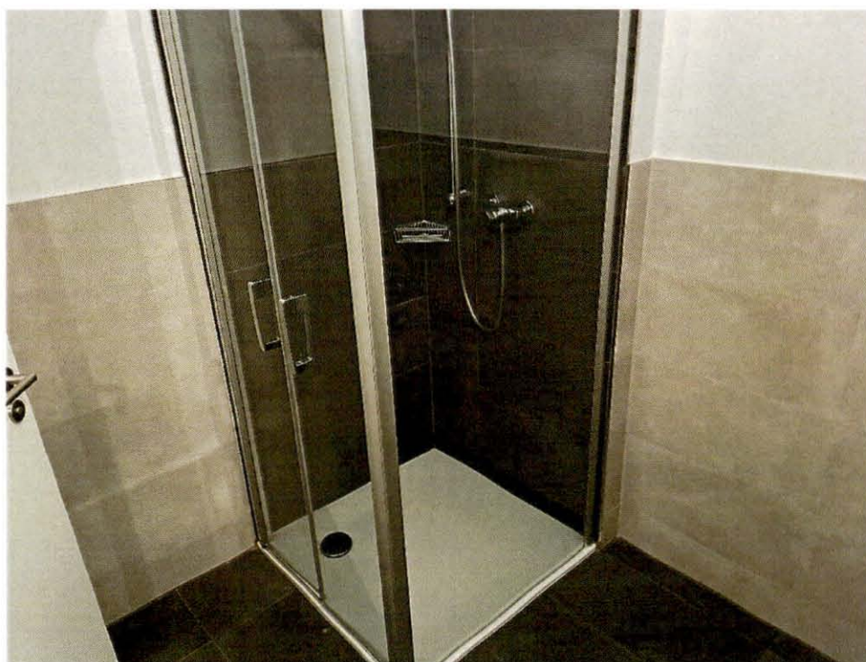
Foto 14: Dusche im UG-Bad
