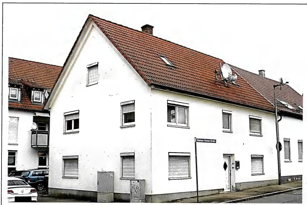
Foto 2: 89264 Weißenhorn, Günzburger Straße 16; Ansicht Südwest
