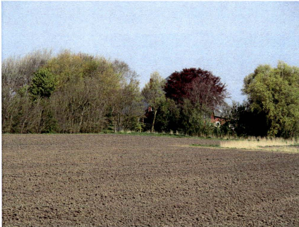
Südostansicht des Wohn- und Wirtschaftsgebäudes
