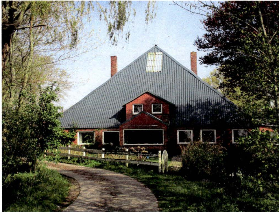
Südansicht des Wohn- und Wirtschaftsgebäudes
