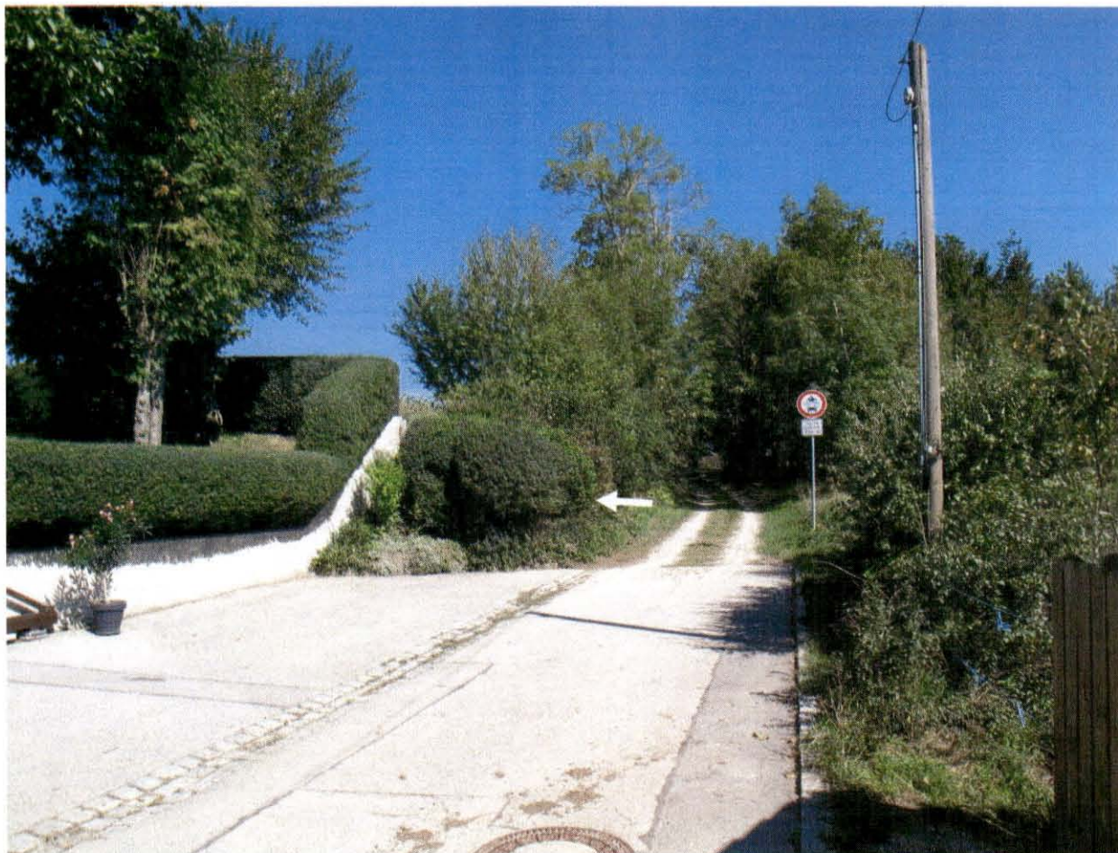
Feldzufahrt auf Höhe Leitenstraße 11 mit der Südwestecke / Feldrain / Aufböschung des Flurstücks links;
