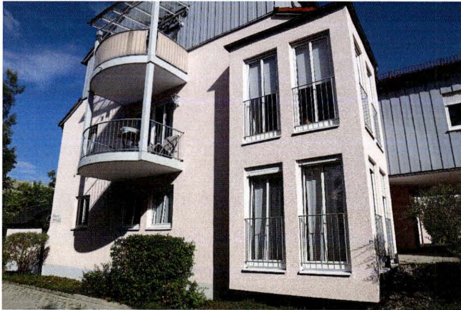
Außenansicht: Mehrfamilienhaus von Nordwesten
