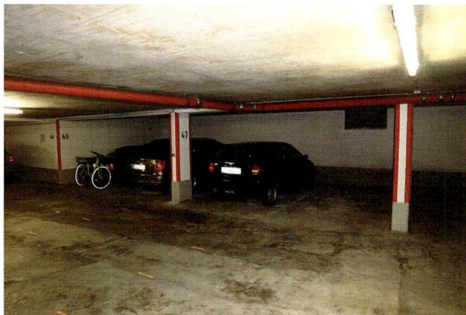
Innenansicht: Tiefgaragenstellplatz SE-Nr. 47
