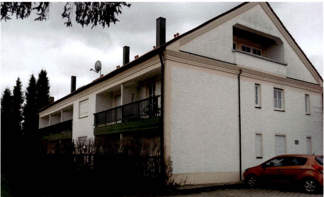
Ansicht auf die Gebäudeanlage von Nordosten
