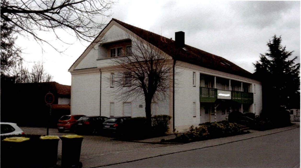
Ansicht auf die Gebäudeanlage von Norden
