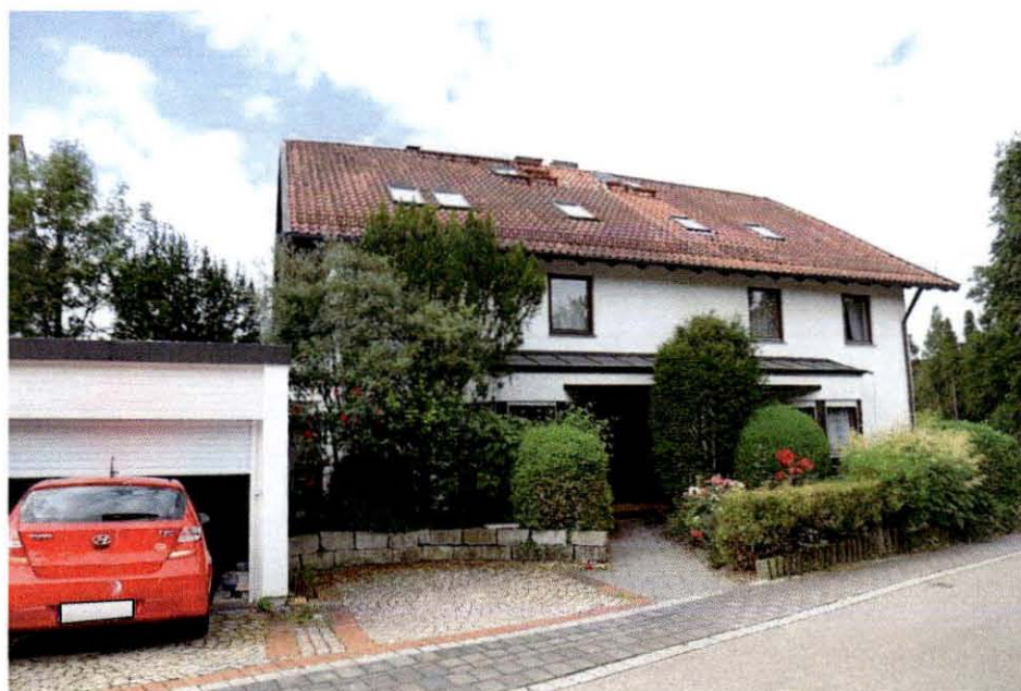
Außenansicht: Einfamilienhaus von Norden
