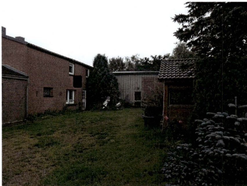
Bild 8: Nordwestansicht des Wohngebäudes mit Blick zur Haustür des Bewertungsobjektes
