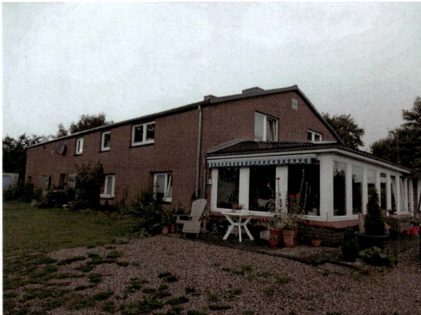
Bild 14: Südostansicht des Gebäudes
