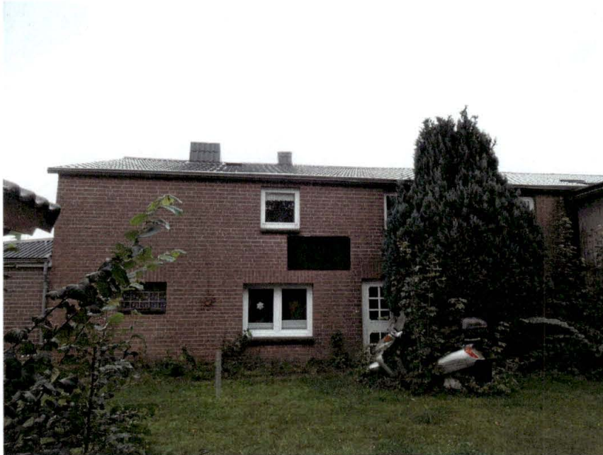
Bild 11: Nordansicht des Wohnhauses mit Wohnungseingangstür zu Wohnung Nr. 2 (Bewertungsobjekt)
