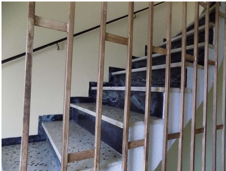
Treppe ins OG
