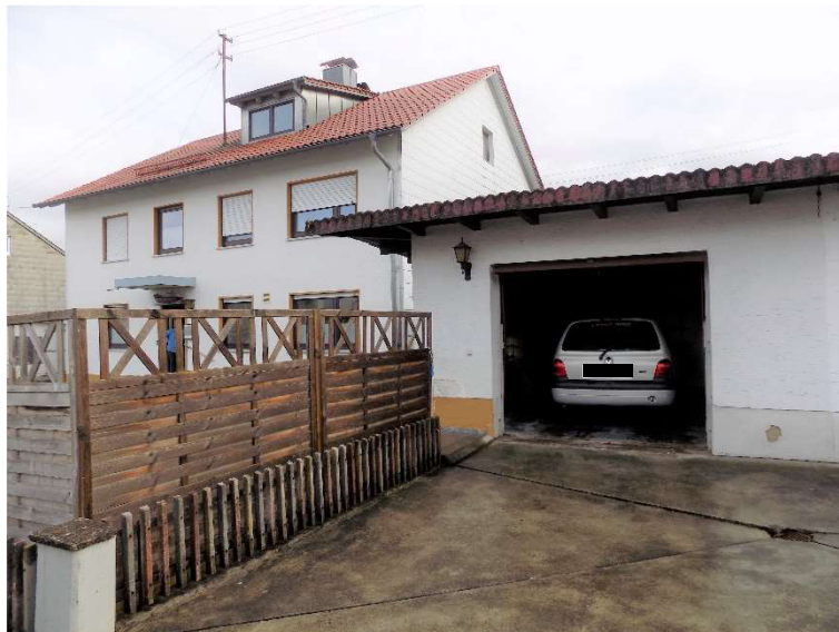
Ansicht von Nordwesten, im Vordergrund. Garage zu Whg. Nr.2
