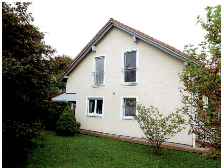
Blick von Südosten auf das Einfamilienhaus
