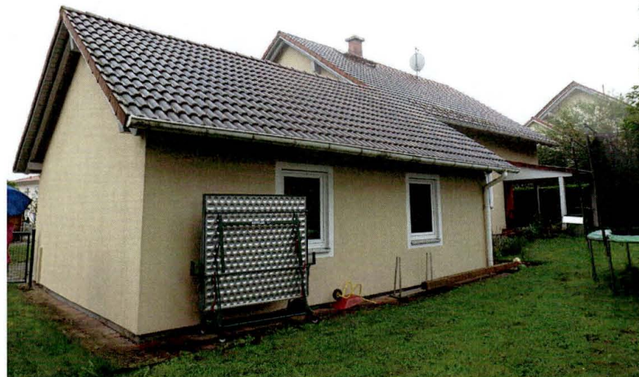
Blick von Nordwesten auf die Doppelgarage und das Einfamilienhaus
