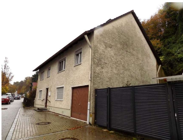
Westgiebel auf der Grenze des Nachbargrundstücks
